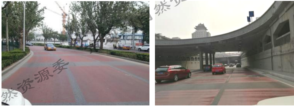
图 6-24 红色彩铺已经广泛用于机动车道减速带了
