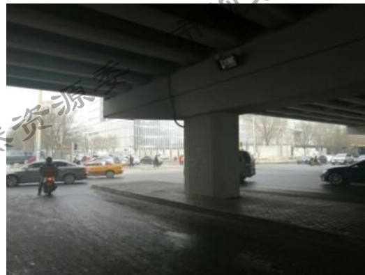
遮挡视线的立交桥墩
