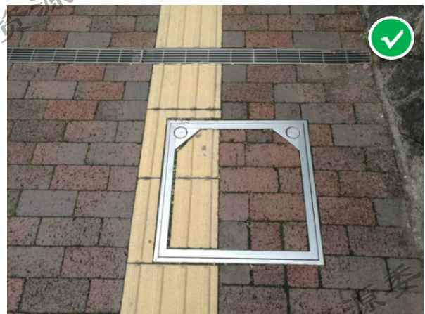
图5-18 井盖不影响盲道（日本）
