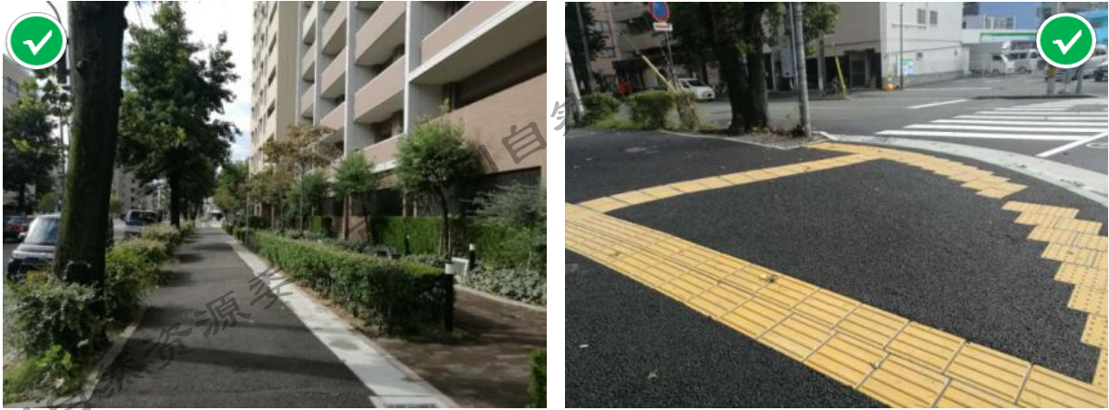
图 5-4 透水沥青的人行道铺装（日本）
