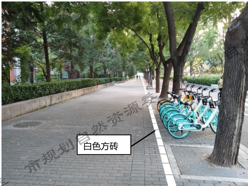
图6-11 用白色步道砖设置的自行车停放引导线
