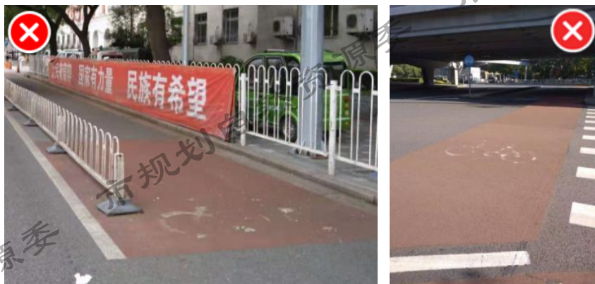
图 6-25 彩铺上面的自行车标志容易剥落
