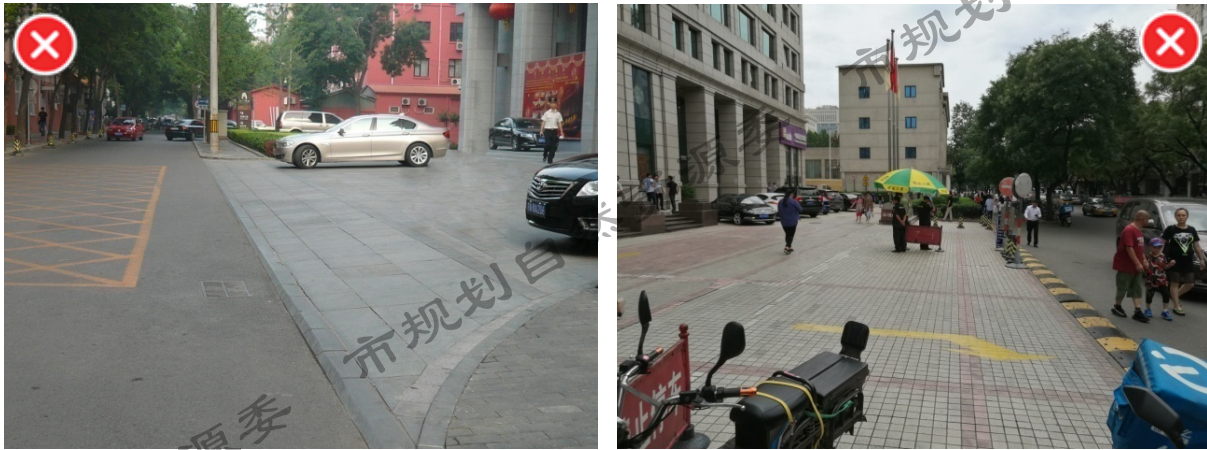
图5-20 过宽的机动车出入口(宽达30米)
